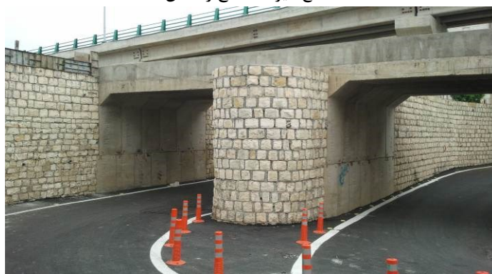
تهیه، حمل، نصب و اجرای باکس پیش ساخته بتنی جهت تبدیل تقاطعات مسطح به غیر همسطح
