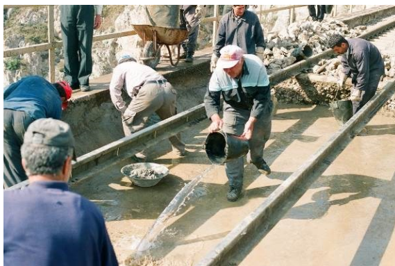
اجرای تفکیک بالاست روی پل‌ها یکی از امور نگهداری پل‌ها
