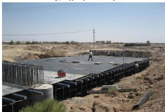
مراحل اجرای دال یک دستگاه پل زیرگذر راه آهن
