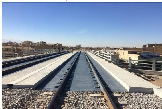
اجرای اسلب ترک روی پل‌ها
