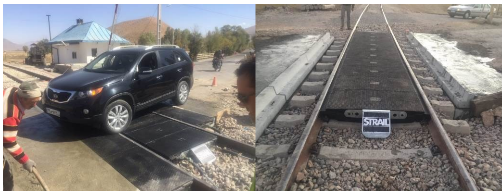
تصاویری از بهسازی و مسطح سازی تقاطع همسطح راه آهن
