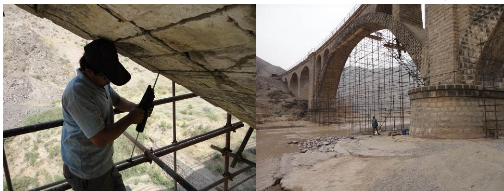
تصاویری از مقاومسازی پل طاقی سنگی راه آهن
